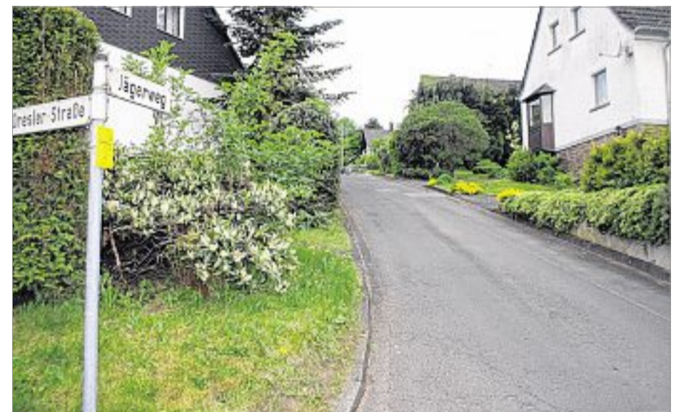
Der Jägerweg in Brachbach bekommt eine neue Kanalisation. Die Anwohner erhielten auf einer Versammlung nähere Informationen zu dem Projekt. Foto: goeb
